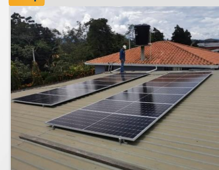
Estación de Servicio Bucaramanga
